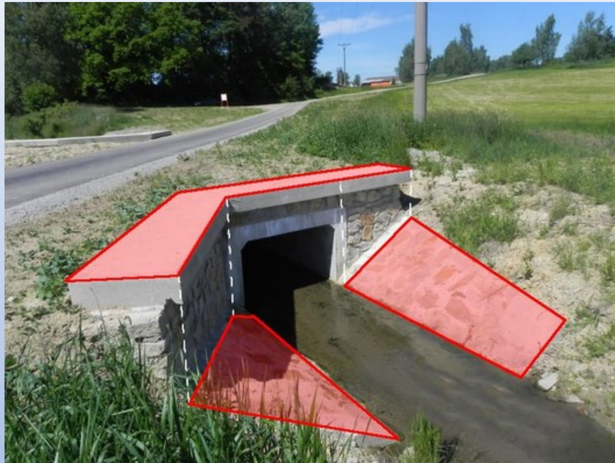
Čelo propustku a stavebně upravené koryto
